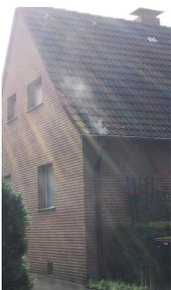
Abb. 1: Fehlanschluss bei Vernebelung
